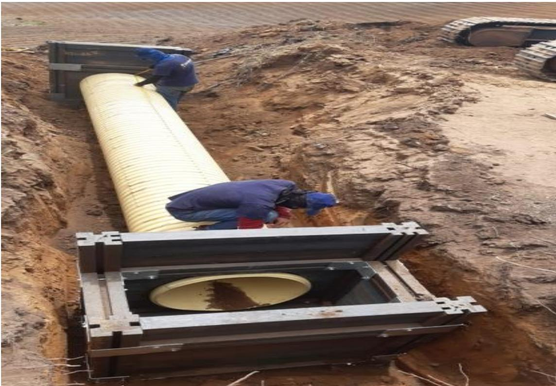
8. **PASO:** Rellenar la excavación hasta cubrir la instalación del tubo.
