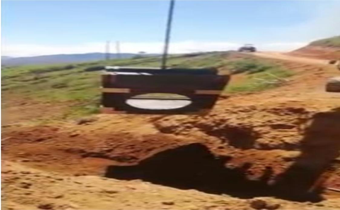
5. **PASO:** Introducir el tubo de PVC por la caja No 2 hasta llegar a la perforación de la caja No 1.
