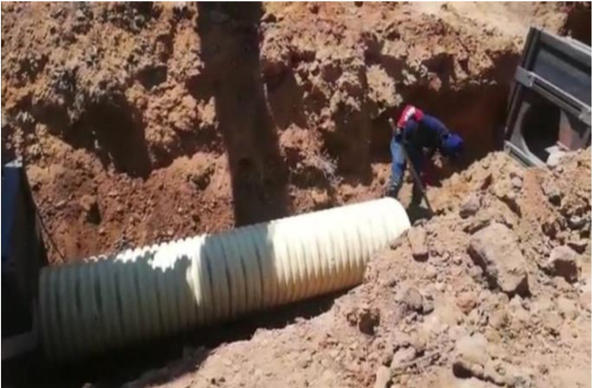
4. **PASO:** Transporte y colocación de la caja de alcantarilla 2 (salida de aguas) al extremo de la excavación.
