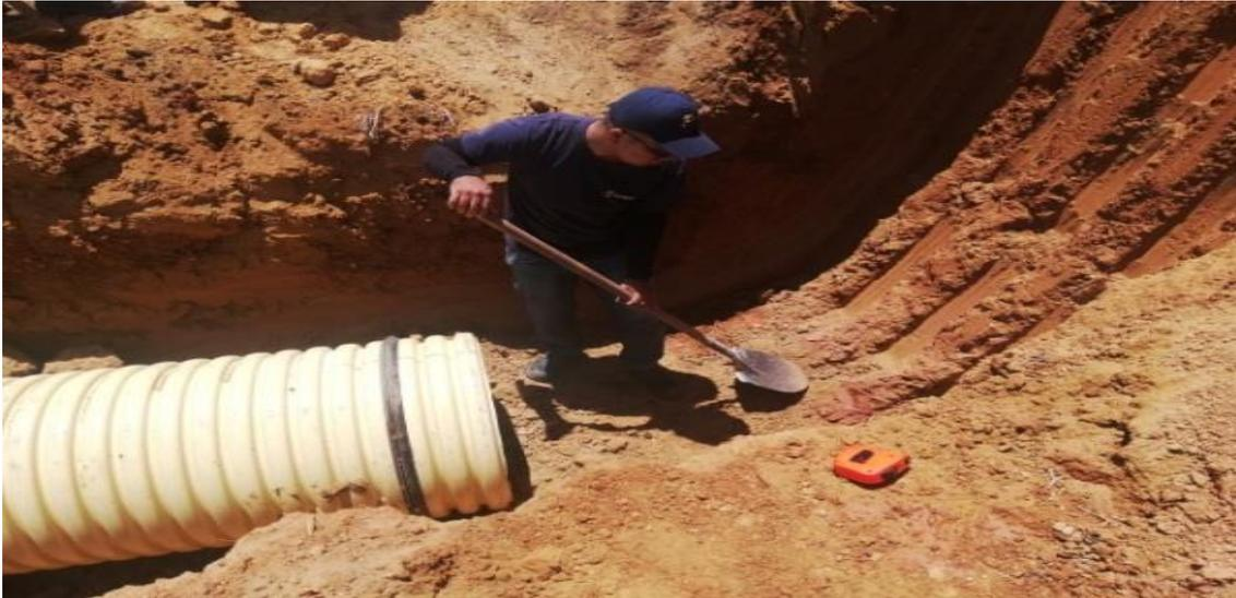
2. **PASO:** Colocación de la caja de alcantarilla 1 (entrada de aguas) dentro de la excavación.
